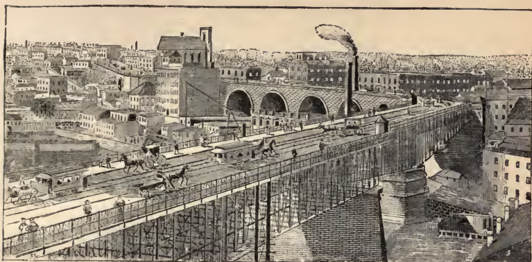
Gran Viaducto Central—Cleveland.
